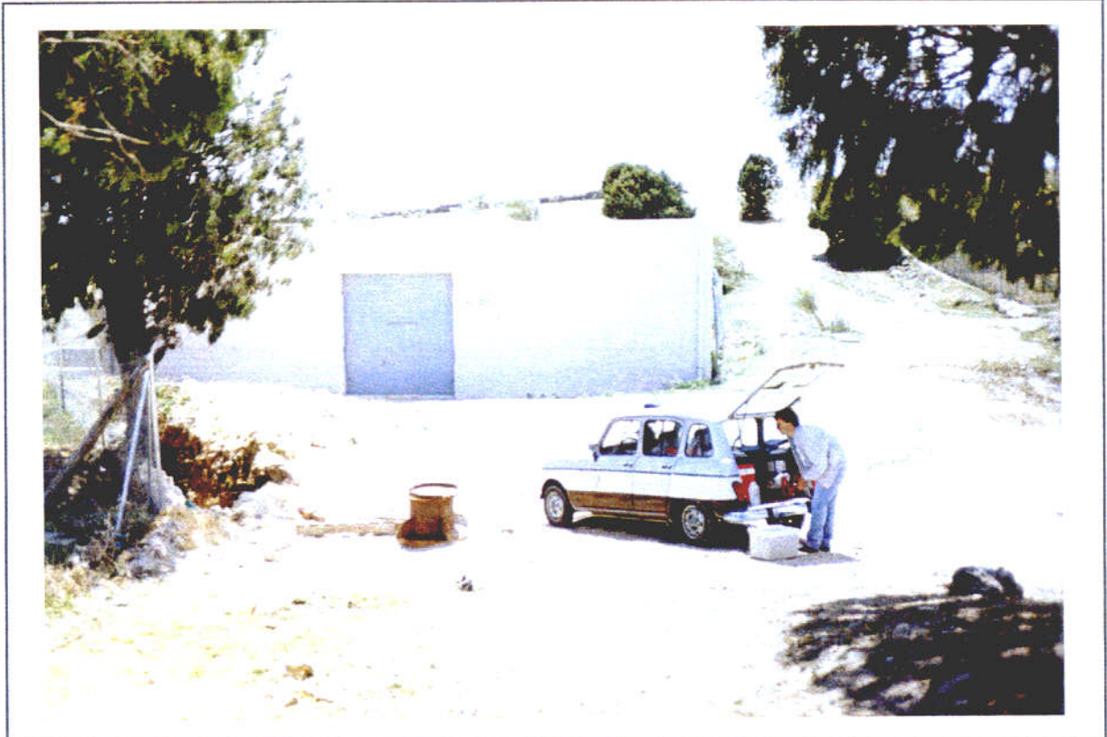
Foto 1. Vista del sondeo sin instalar, junto a la ETAP de San Agustín.
