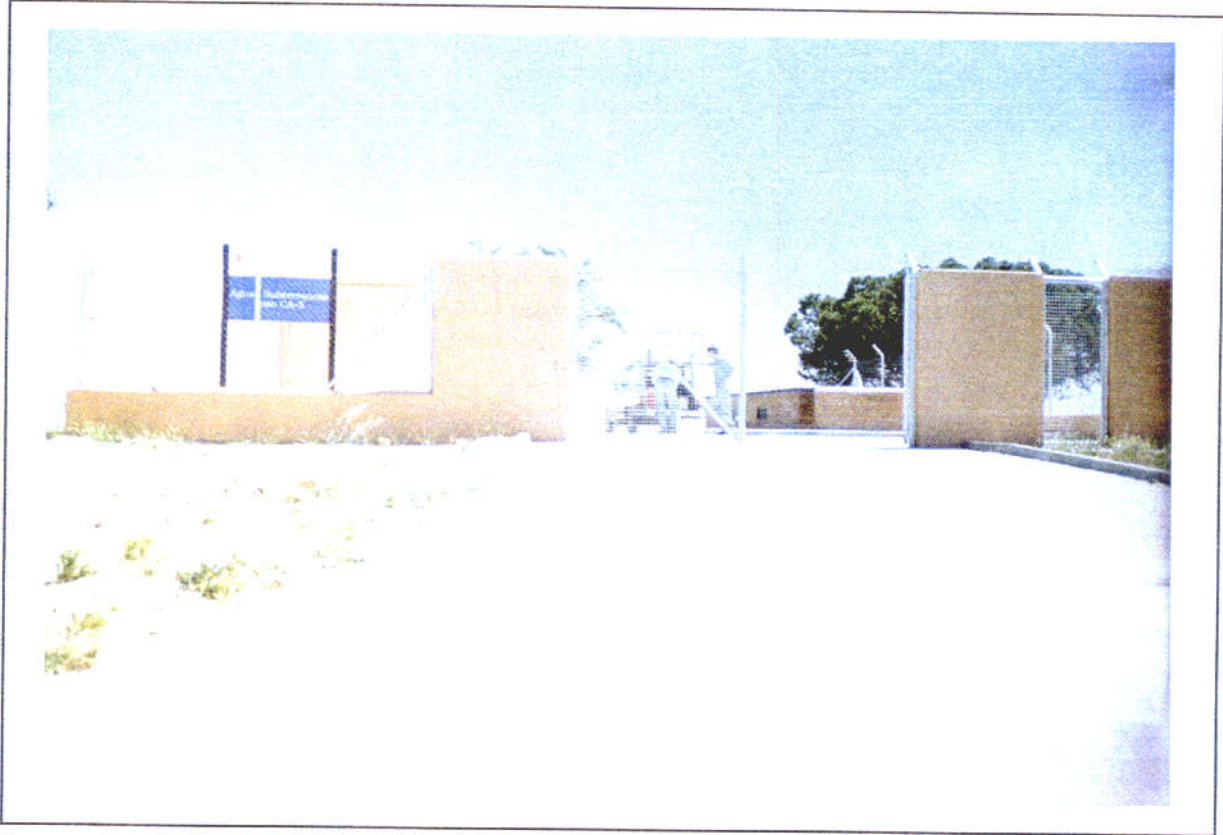
Foto 1. Vista de la entrada al sondeo, situado en el camino de servicio del C. Y. II a el depósito de El Goloso.
