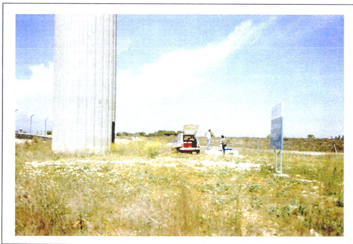
Foto 2. Vista del sondeo y la torre de elevación.
