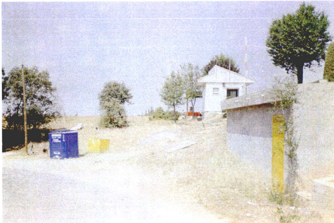
Foto 60. A la derecha está el sondeo dentro de la caseta con la puerta amarilla. La caseta del fondo es la de control de entrada a la urbanización.
