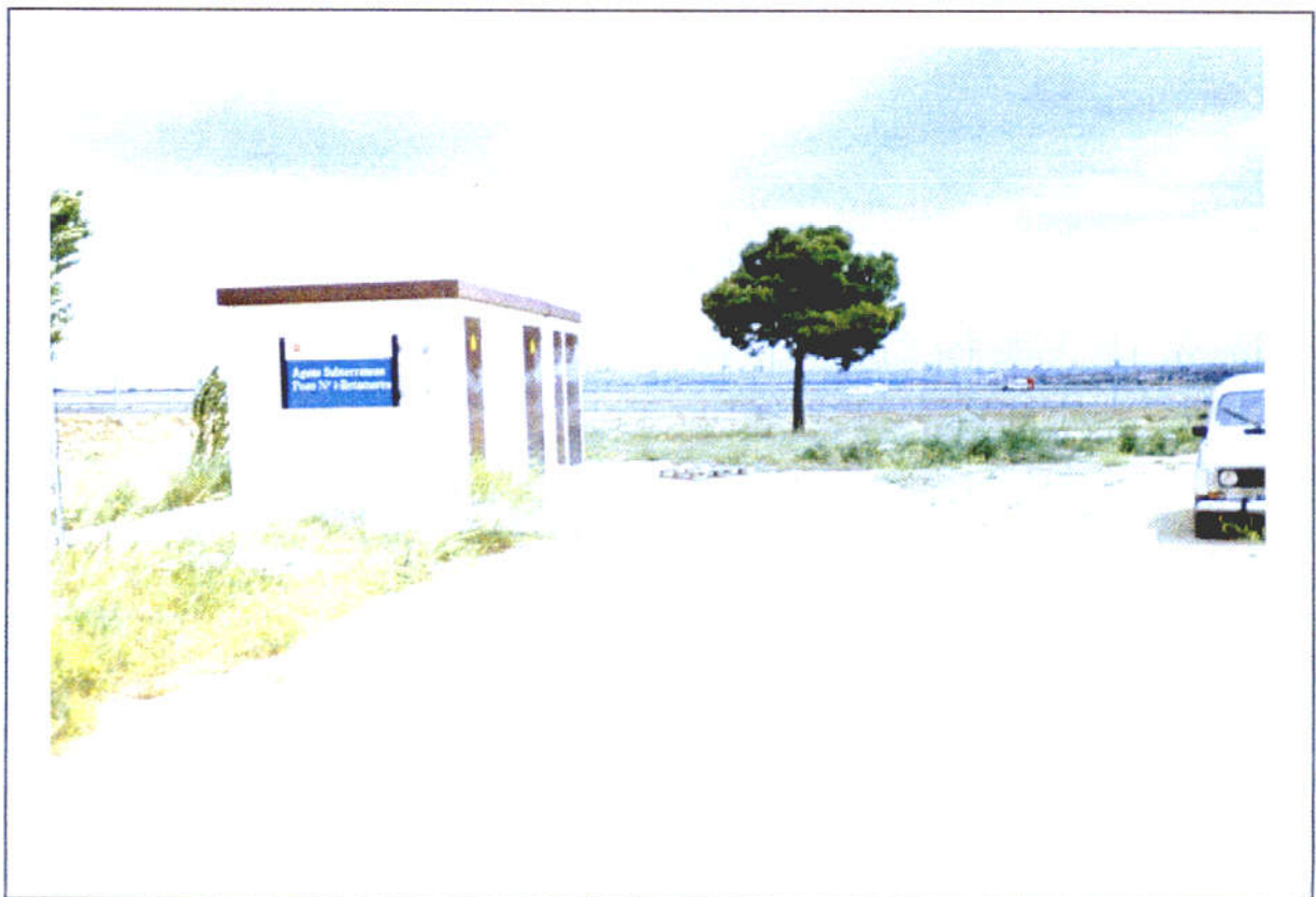
Foto 2. Caseta de controles del sondeo, situada en una esquina del depósito a 80 m. del sondeo
