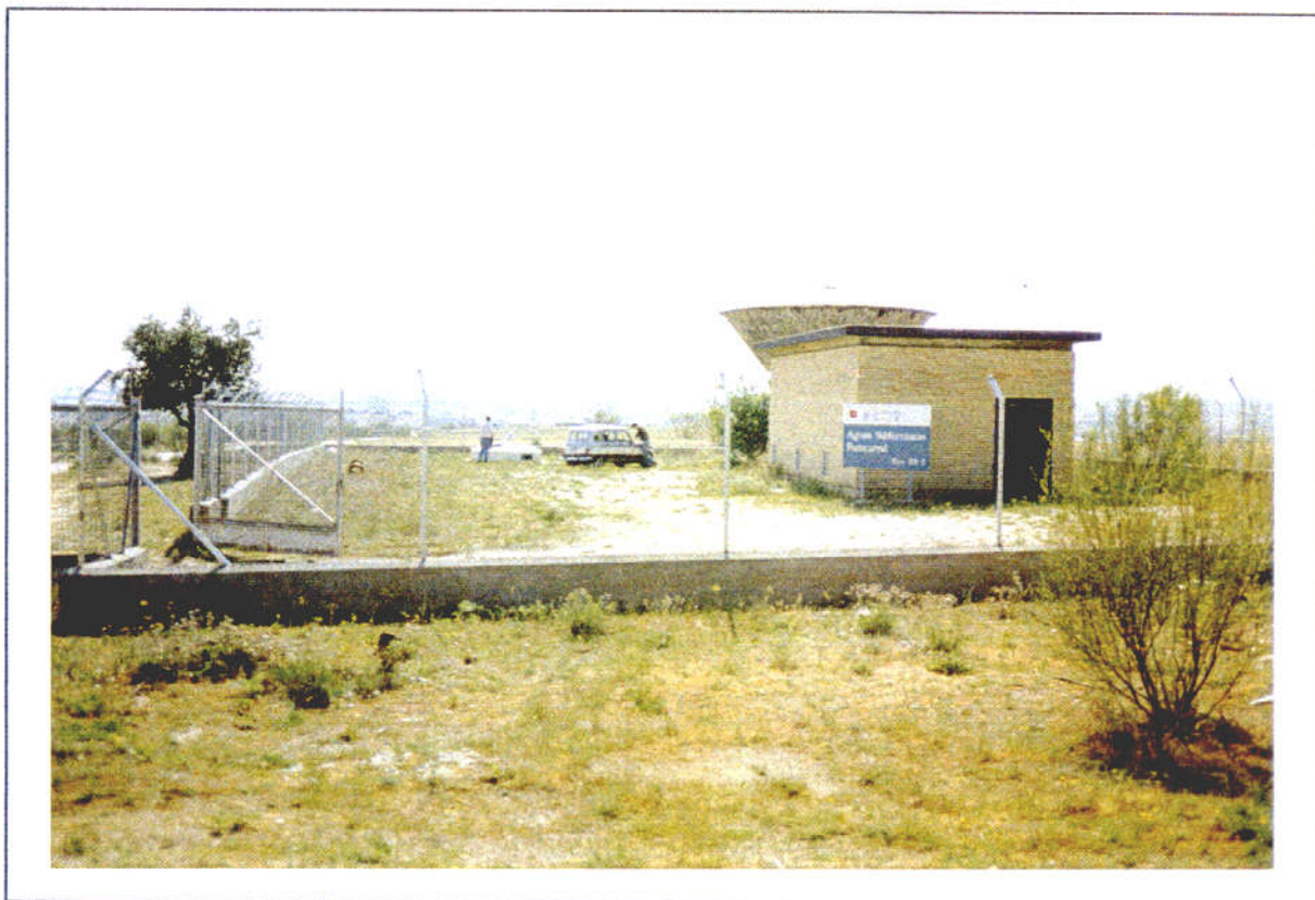
Foto 1. Vista del sondeo desde el exterior del recinto vallado.
