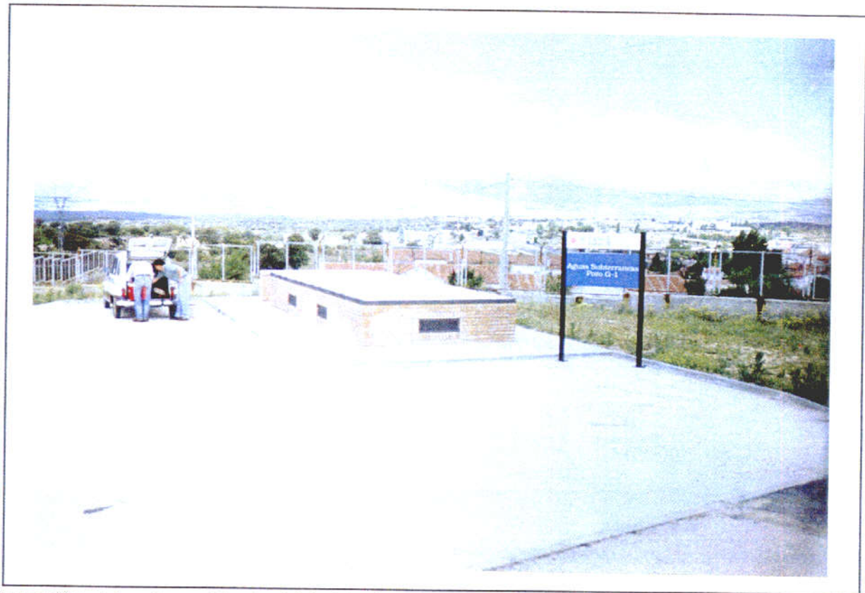
Foto 1. Vista del sondeo en el interior del depósito de El Goloso, en el extremo norte. Junto a el barrio de El Goloso.
