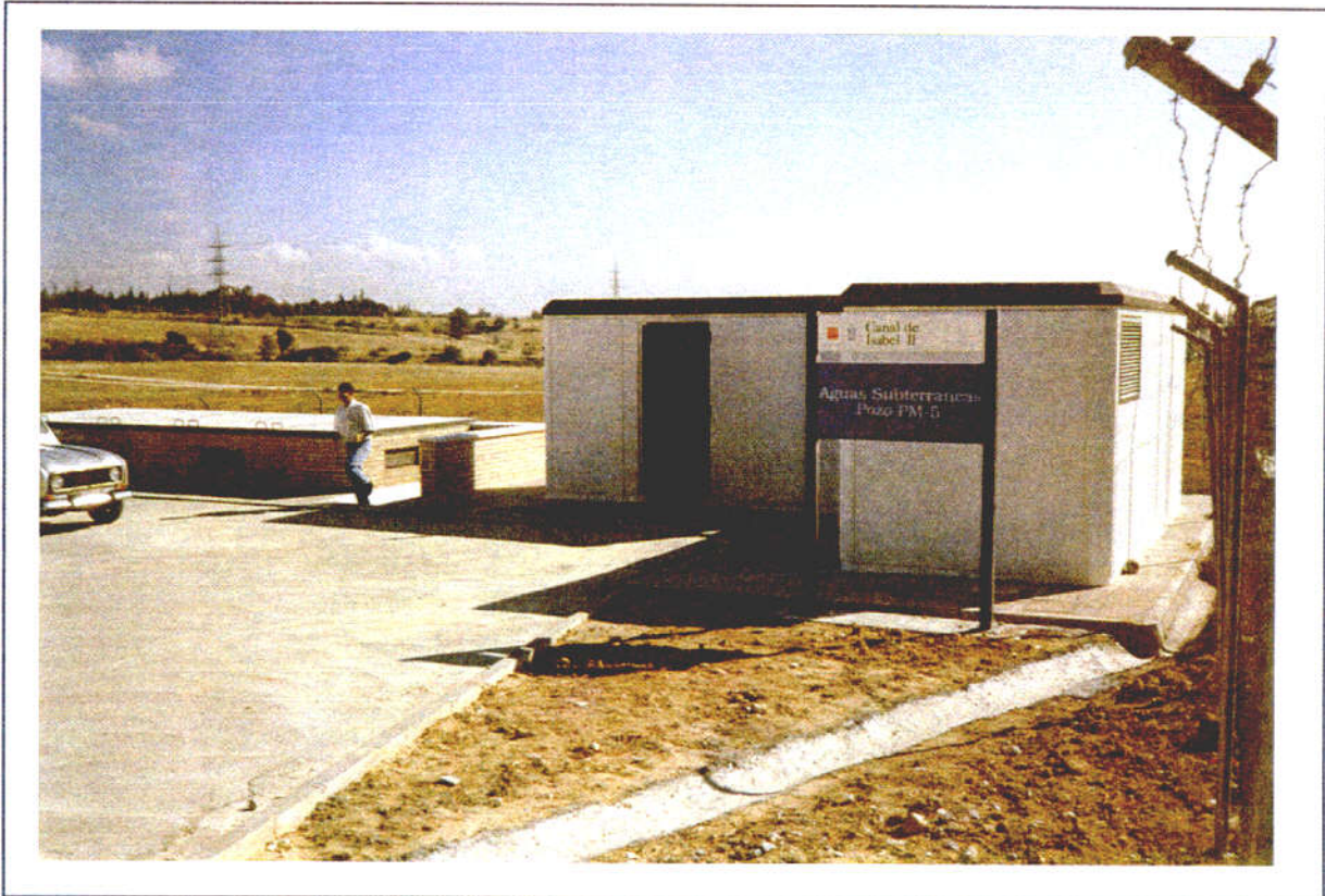
Foto 1. Vista del sondeo situado en el extremo sur de la instalaciones del C. Y. II en Majadahonda
