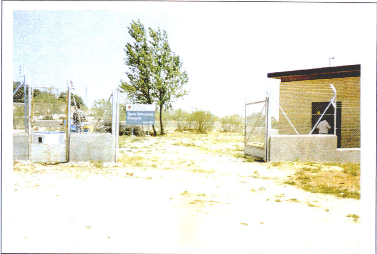
Foto 1. Vista del sondeo a la izquierda y la caseta de control. A la izquierda se observa la valla de ladrillo del Monte del Pardo.
