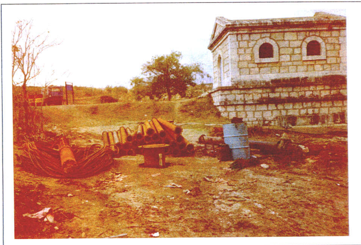
Foto 1. Vista del sondeo después del ensayo de bombeo.
