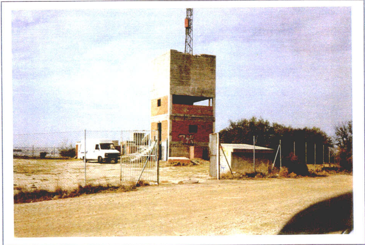
Foto 3. Vista del depósito de la urbanización. Aquí se recoge la muestra del pozo del Ayuntamiento. El pozo Brezos se encuentra a unos 50m. de aquí en una finca vallada. Es la parte más alta de la urbanización.
