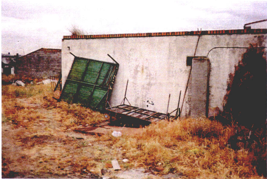
Foto 5. El sondeo se encuentra tapado por una chapa de hierro. Situado en los almacenes de limpieza del Ayto., donde está el depósito del pueblo. La muestra se recoge a la caída del depósito.
