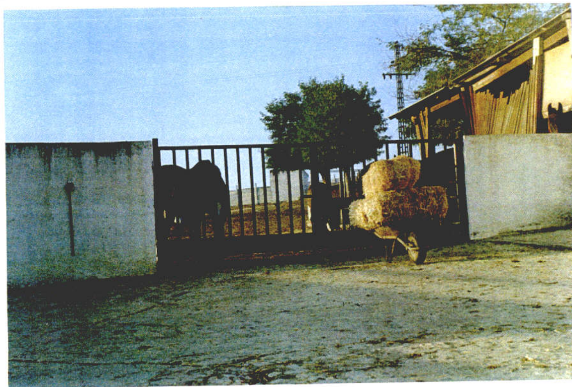
Foto 34. El sondeo se encuentra en la caseta blanca al fondo del corral.
