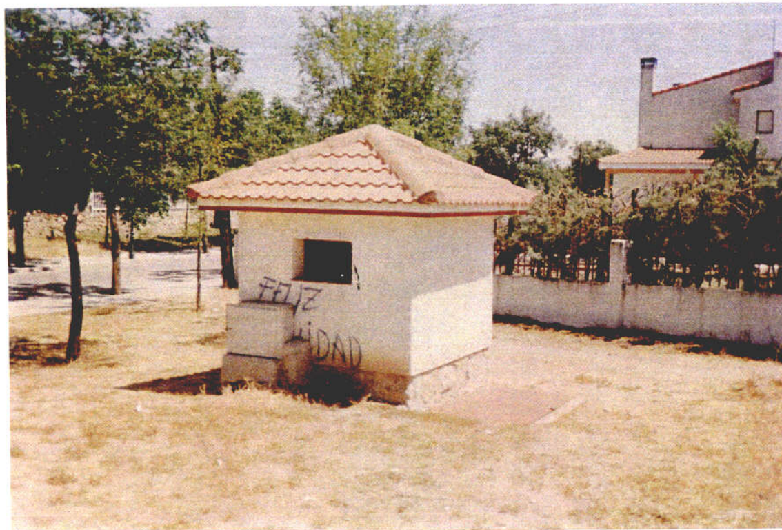
Foto 11. Vista de la caseta del sondeo en el casco urbano de Brunete. Controlado por el C.Y.II.
