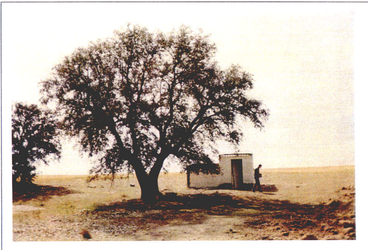
Foto 23. Vista de la caseta del sondeo en el interior de la finca. La casa de los dueños se encuentra a unos 300m. del sondeo, por un camino de tierra.
