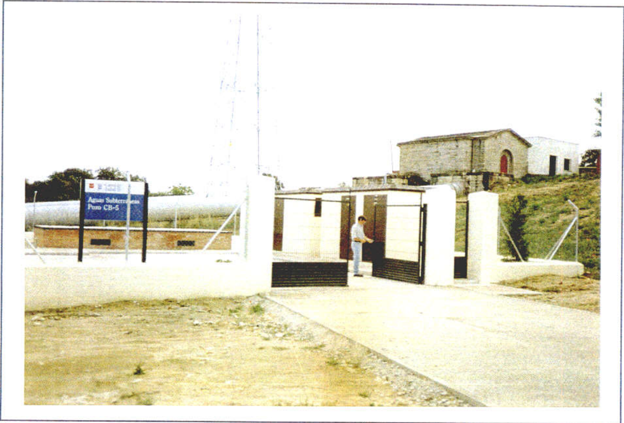
Foto 1. Vista del sondeo desde la carretera al Castillo de Viñuelas. Al fondo el sifón de El Bodonal.
