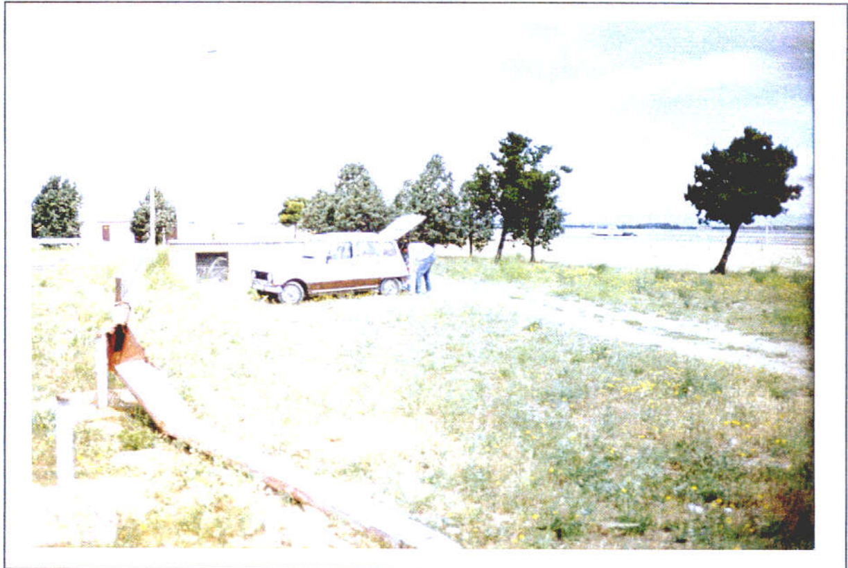
Foto 1. Vista del sondeo en el interior del depósito de Retamares. Al fondo, la M-40 en las inmediaciones de la N-V
