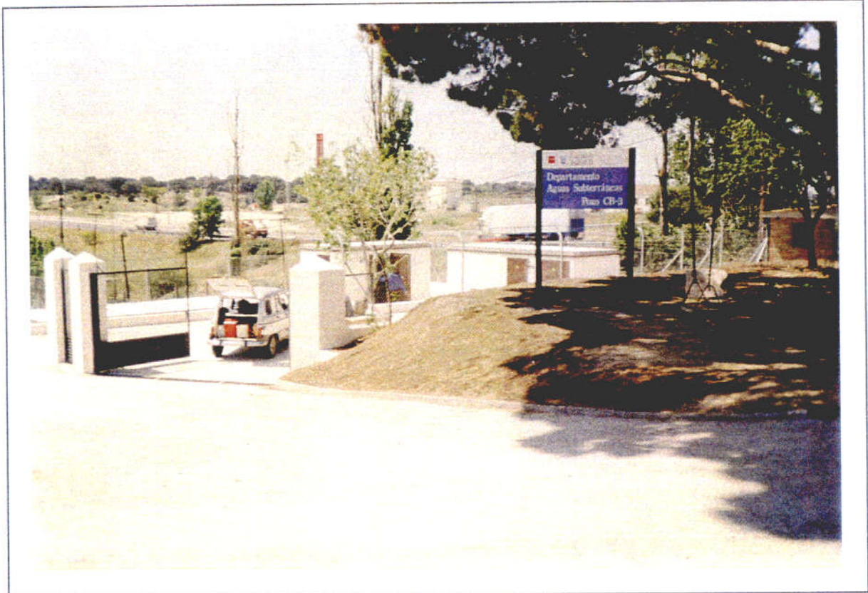
Foto 1. Vista de la entrada al sondeo. Al fondo la estación de cercanías de El Goloso.
