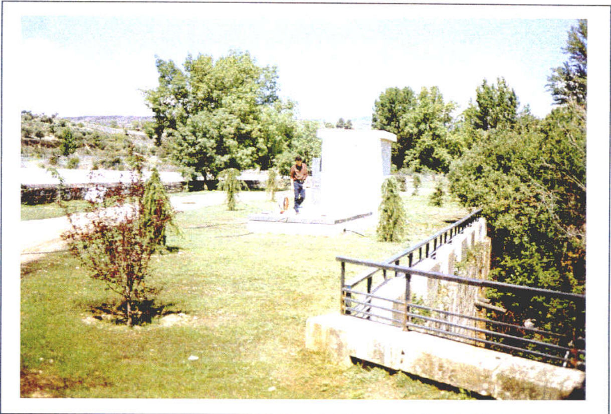
Foto 1. Vista del sondeo después de las obras de acondicionamiento exteriores dentro de la Subcentral Hidroeléctrica de Torrelaguna.
