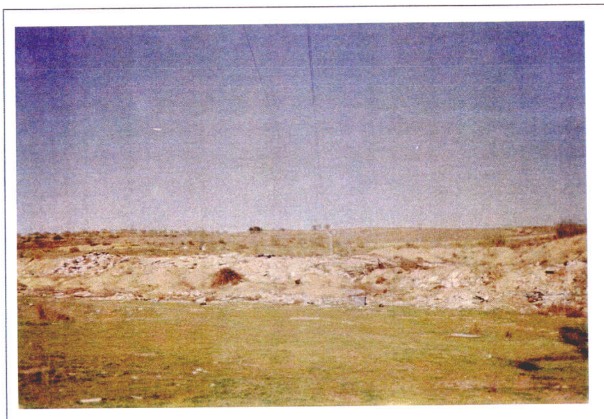
Foto 2. Vista del vertedero de estériles al Norte del CB-11. Detrás del vertedero se encuentra la carretera de Alcobendas a El Goloso.
